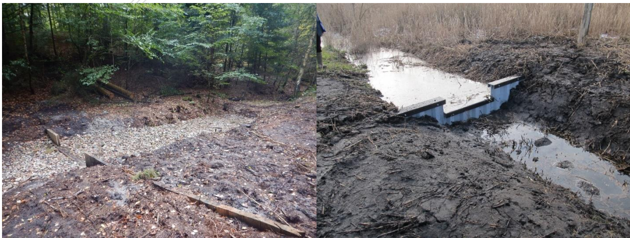
Abbildung 7-12: Beispiel Ausführung Holz- oder Kunststoffspundwand
