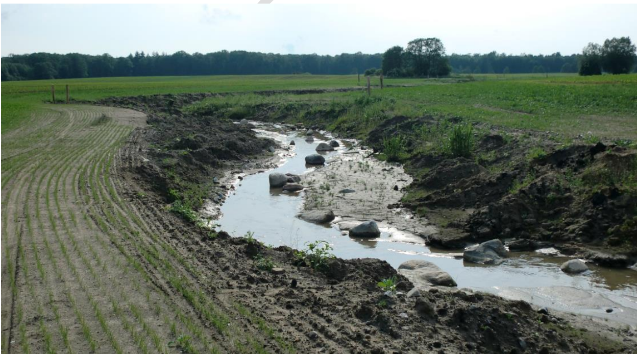
Abbildung 7-1: Neuprofiliertes Bachbett mit Wasserwechselzone (Haubach)
