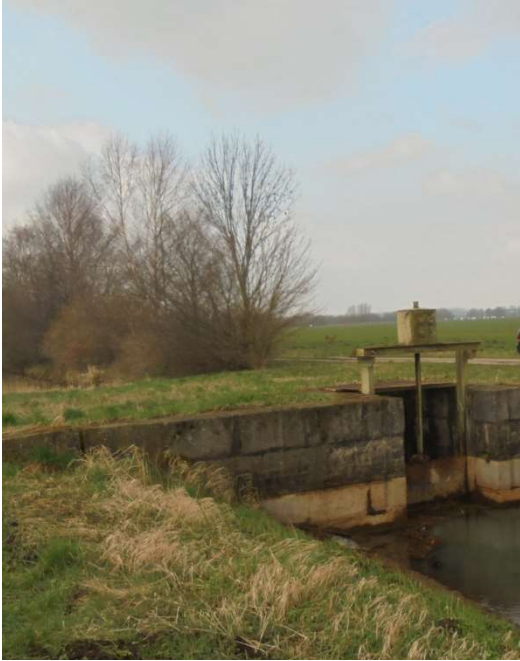
Abbildung 2: Stau mit Wegedurchlass an Stat. 5+750
