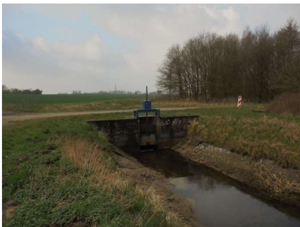
Abbildung 1: Staubauwerk mit Wegeüberfahrt an der Stat. 2+500
